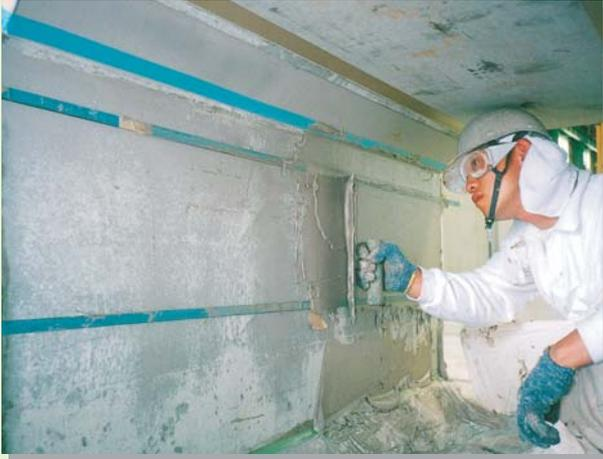
ケタコートシリーズは、日本道路公団の「コンクリート橋桁端部防水システムの防水層の品質規格」に適合する、速硬化性の防水材料です。
