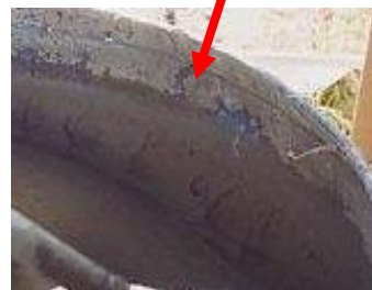
良好な練混ぜ状態
