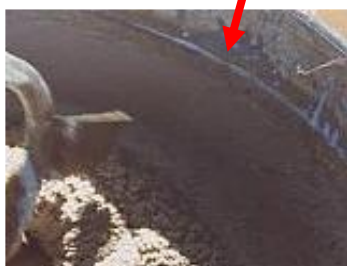
不完全な練混ぜ状態
