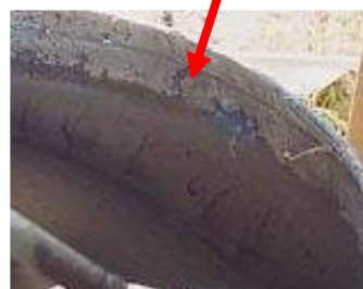
良好な練混ぜ状態
